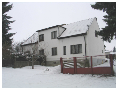
RD Č.P. 83 NA P.Č. ST. 74
