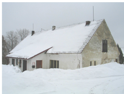
RD Č.P. 79 NA P.Č. ST. 44
