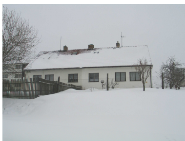
RD Č.P. 874 NA P.Č. ST. 781
