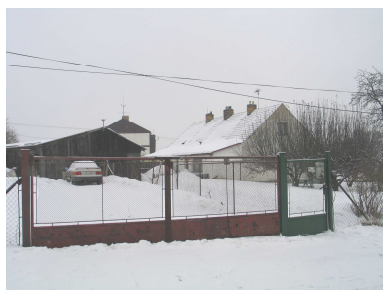
RD Č.P. 875 NA P.Č. ST. 780
